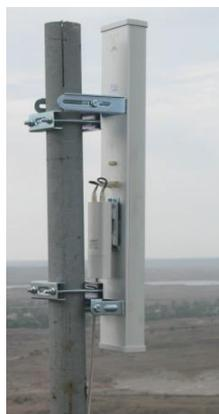
Рис. 10. Точка доступа центра беспроводной сети связи СССМ
