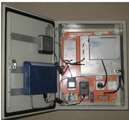
Рис. 9. Полевой пункт системы СССМ для подземной установки
